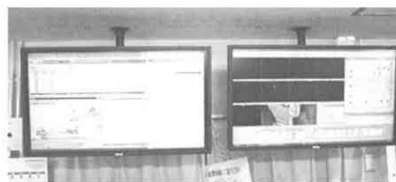
図8 ネットワーク (左) 及びデータセンター (右) の監視画面
